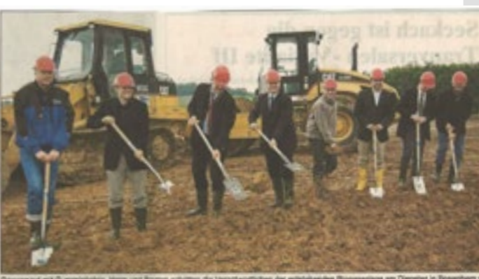
Gespannt mit Gurnischaalen, Helm und Spaten schritten die Verantwortlichen der entstehenden Biogasanlage am Dienstag in Rosenberg zur Tat. Das Bild zeigt von links Harald Schäfer von der Firma Müller-Bau, Klaus Ziemann vom Ingenieurbüro Grunlich und Partner, Dr. Mathias Lenz, Geschäftsführer der AWO, Landrat Dr. Armin Brühl, Bürgermeister Gerhard Beer, die Frau von der Firma Umwelttechnik Substanz, Christoph Nasser von der Firma Getrag und Alvin Gatz vom Maschinenring beim Spatenstich.
