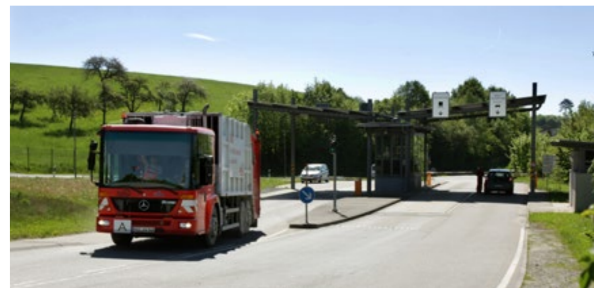
Inbetriebnahme des neuen Wiegeterminals am Standort „Sansenhecken“ mit getrennter Ein- und Ausgangswaage.
